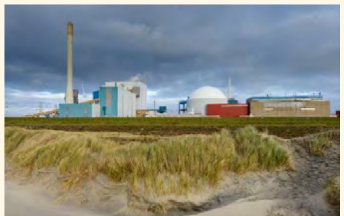
▲ Kerncentrale Dodewaard; in 1997 gesloten; de ontmanteling van de inwendig besmette radioactieve gebouwen staat gepland voor 2045
